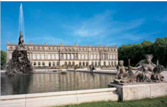
Nördliches Bassin mit dem Fama-Brunnen und der Gartenfassade des Königsschlusses
